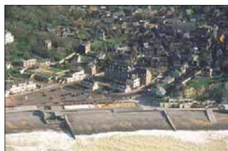
La digue protégeant la basse vallée de l'Yères contre les incursions marines a été détruite une fois par la tempête.
